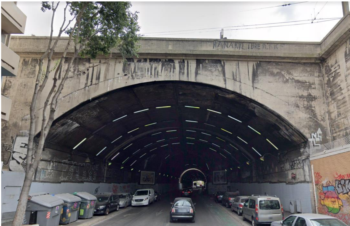
Figure 25 : Entrée nord du tunnel du Boulevard National à Marseille.
