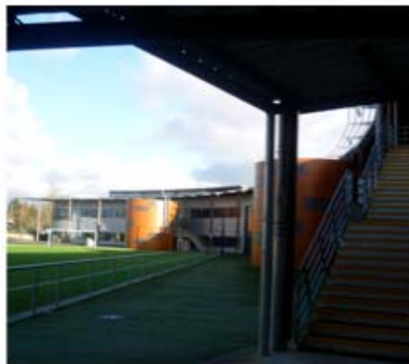
Vue sur le bâtiment scolaire
