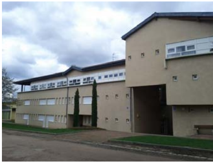
Vues extérieures du bâtiment
