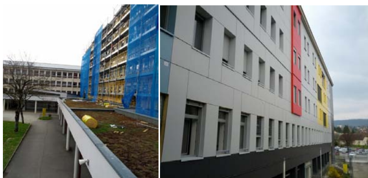
Partie de l'internat en rénovation Partie rénovée de l'internat
